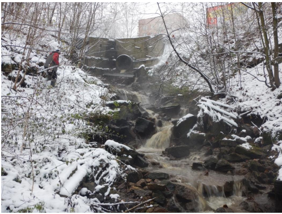
Рис. 6.7 – Сброс канализационных вод в пределах водоохранной зоны р. Луга – г. Кингисепп
