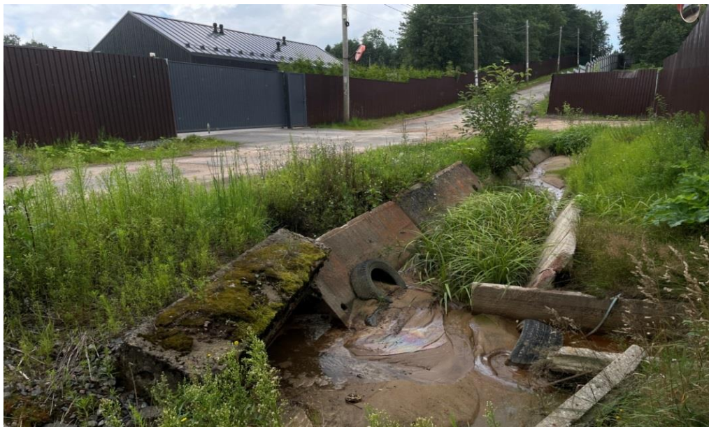
Рис. 6.21. Ручей Без названия – п. Ленинское (05.08.2024), начало канализованного участка, наносы в русле, захламление
