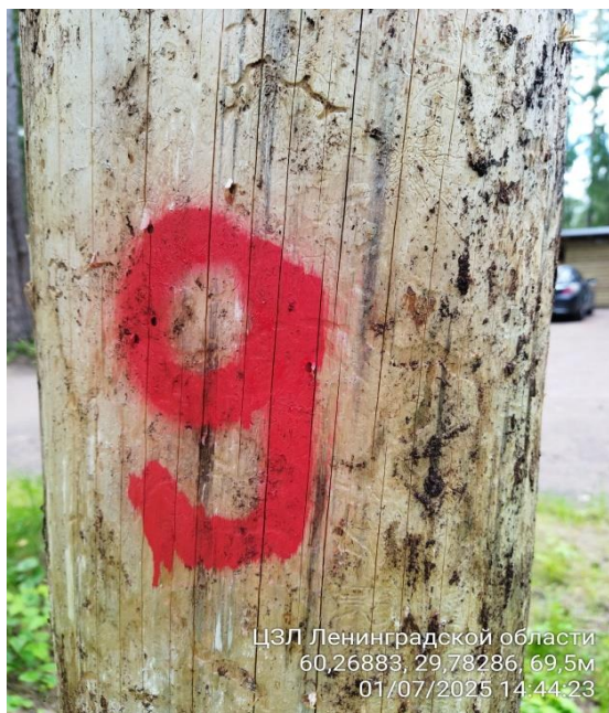
Фото № 1.2 Стволовая и комлевая гниль, трещины
